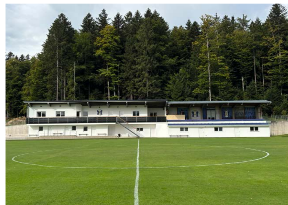
Das Klub-Gebäude der Sportunion Nebelberg nach der Modernisierung
