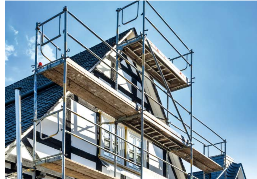
Eine umfassende Sanierung steigert den Wohnkomfort und den Wert der Immobilie
