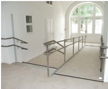
Markierungen an Treppe und Rampe
